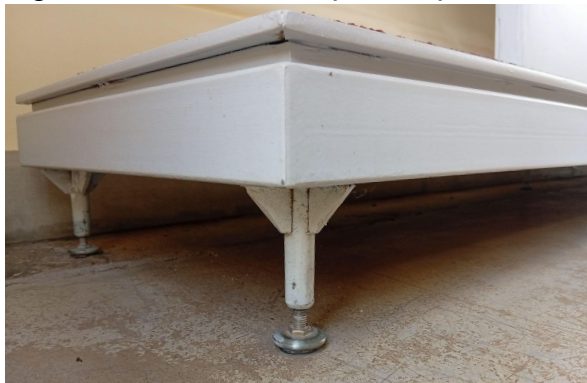
Figura 30 - Detalhe do pé dos pedestais
