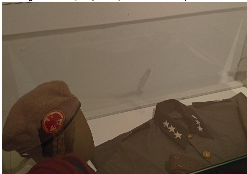
Figura 22 - Deposição de particulados no topo da vitrine
