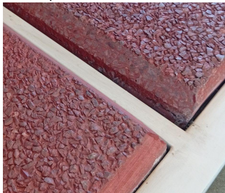
Figura 31 - Detalhe da base dos pedestais do térreo
