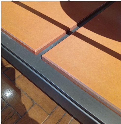
Figura 33 - Detalhe da base dos pedestais do segundo andar
