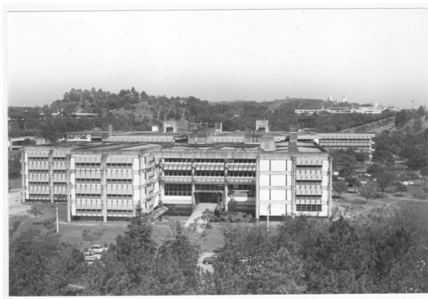
Figura 1 - Construção do prédio da Biblioteca Central
