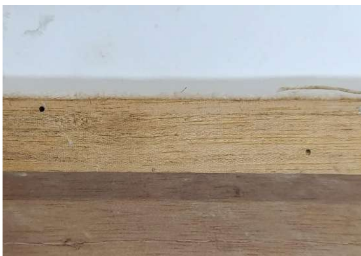
Figura 29 - Orifícios no chassi
