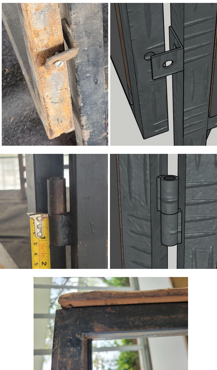
Figuras 32 - 36 - Abas metálicas: original e modelo 3D. Dobradiça Gonzo: original e modelo 3D. Ripas de madeira: original. Respectivamente, esquerda para direita.
