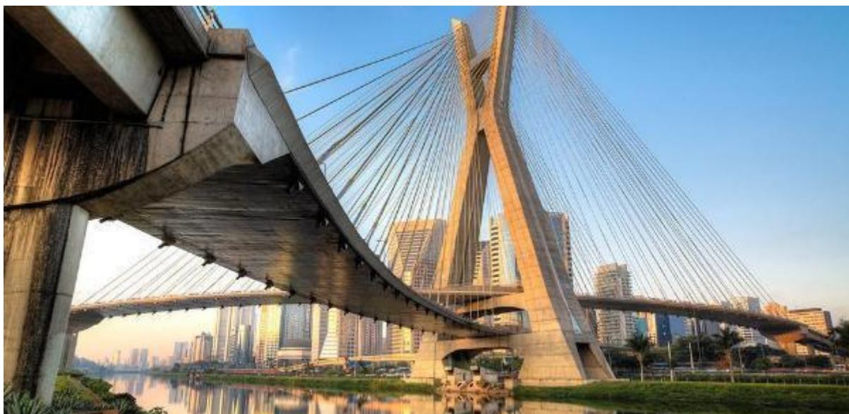
Figura 22 — Ponte Octavio Frias de Oliveira
