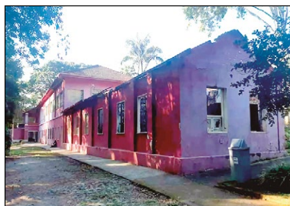
FIGURA 81 – Reserva Técnica 1 ao fundo da edificação principal. Fonte: Corpo de Bombeiro Militar de MG, 2020.
