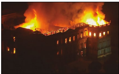
FIGURA 84 - Edificação do Museu Nacional (UFRJ) tomada por chamas e fumaça devido ao incêndio.
