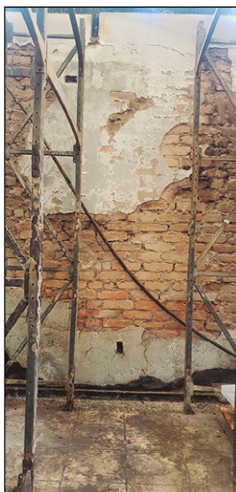
FIGURA 91 – Sala A: ausência de fuligem na parede Fonte: AGE Almada, 2020.
